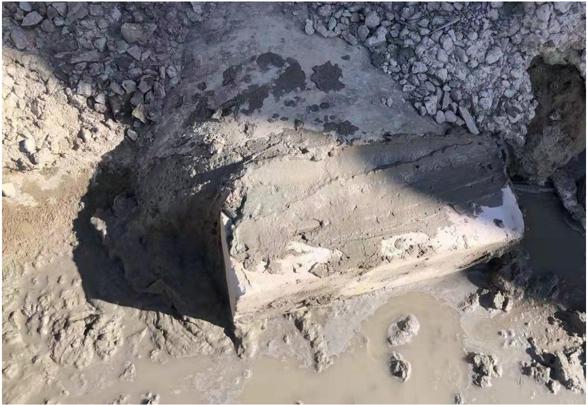
排水沟、沉淀池封口
